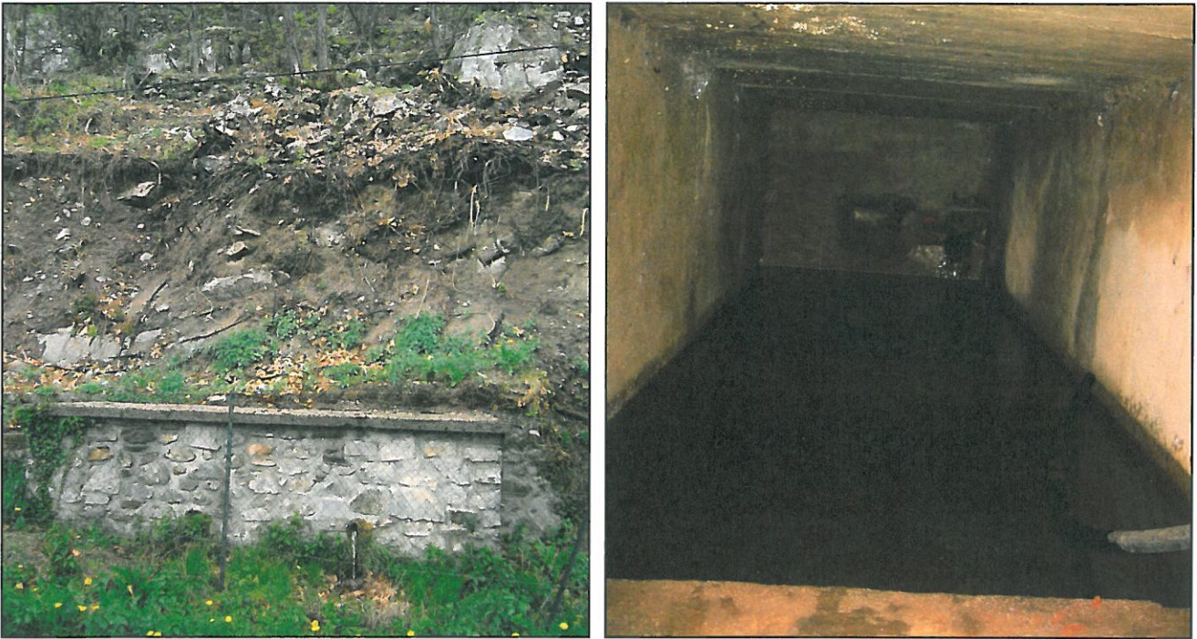
Figure 6 – Captage de la source des Bouscarasses (vue extérieure avec grillage du Périmètre de Protection Immédiate côté route et vue intérieure avec arrivée du canal au fond)
